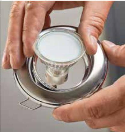
Otez la bague de support et posez l'ampoule. Pour la fixation de celle-ci, remplacez la bague.
