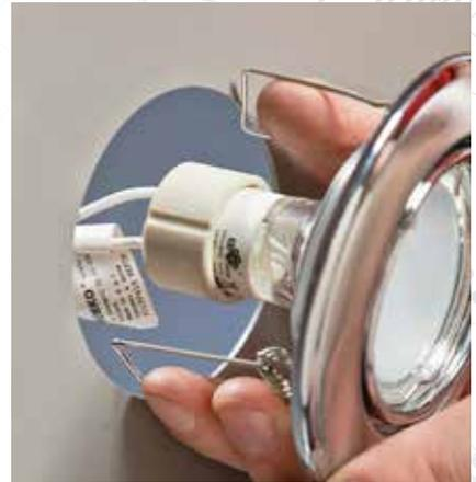
Comprimez les deux ressorts. Insérez l'ampoule avec le support dans l'orifice prévu du fronton 33810105587. Relâchez les deux ressorts.
