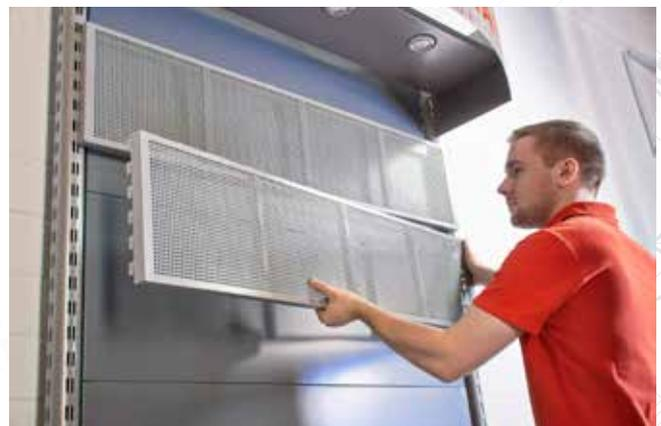
Fixez les parois arrière en tôle perforée 338003964639 à la colonne.
